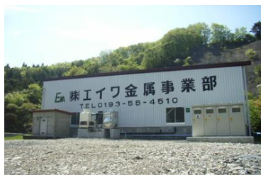
(株)エイワ金属事業部工場 (釜石市)
