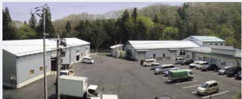
移転新築後の工場
