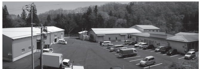
移転新築後の工場
