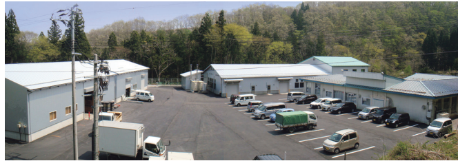
移転新築後の工場
