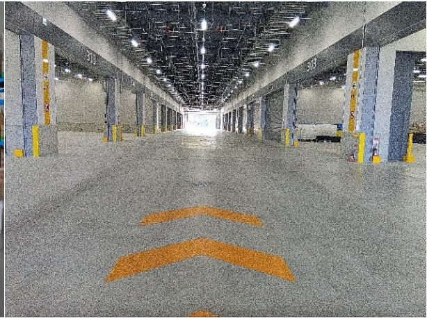
プロロジスパーク盛岡の倉庫内
